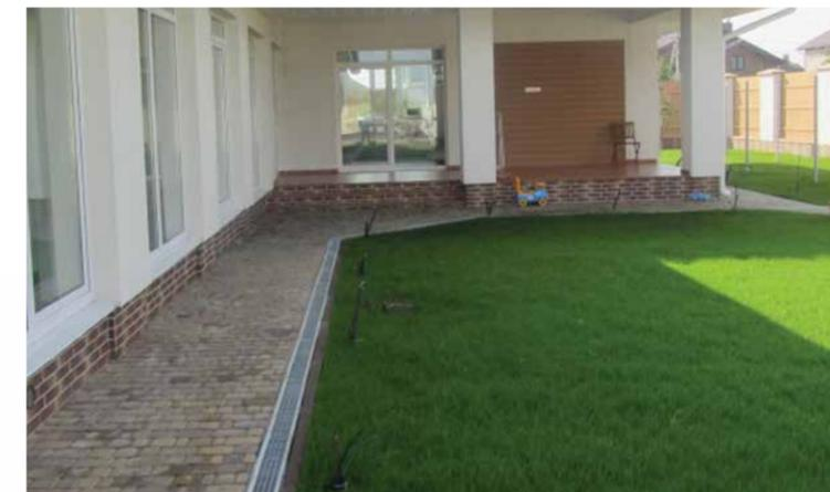
! Систему можно собрать без применения дождеприемника, для этого линия закрывается заглушками с двух сторон и к лотку снизу / сбоку / через заглушку подключается водоотводная труба.
