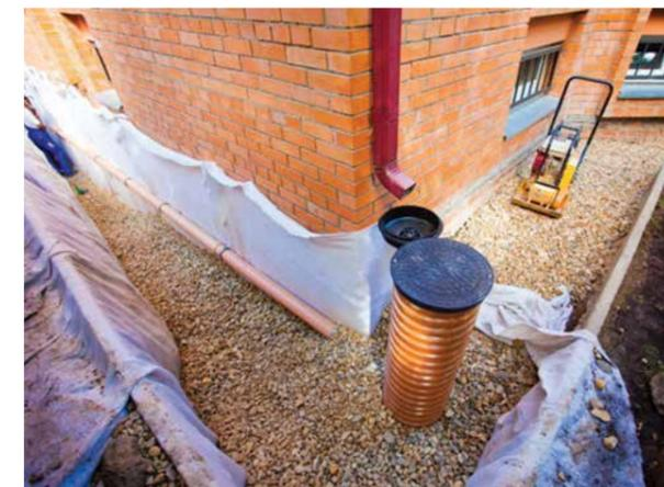
случаях хватит конструкции размером в поперечнике 35–50 см – ровно столько, чтобы можно было без проблем спустить внутрь шланг для промывки или откачки.
