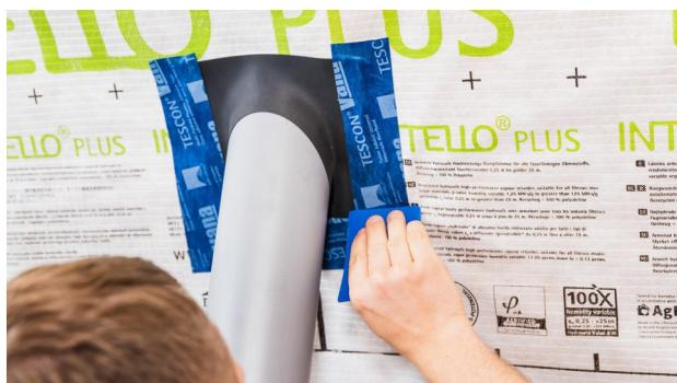
**13. Соединение с трубами и кабелем**
