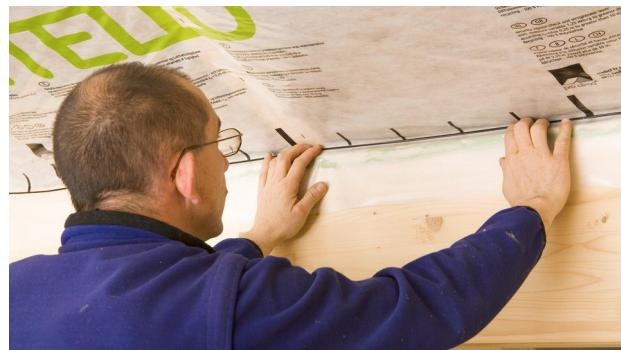
**11б. Соединение со строганой древесиной**
