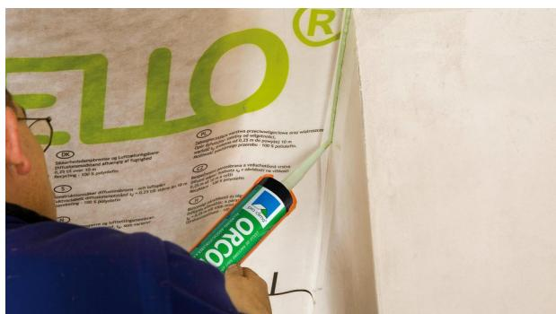
**12а. Соединение с оштукатуренным дымоходом (утепленный или двухстеночный)**
