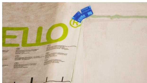
**12б. Соединение с оштукатуренным дымоходом (утепленный или двухстеночный)**
