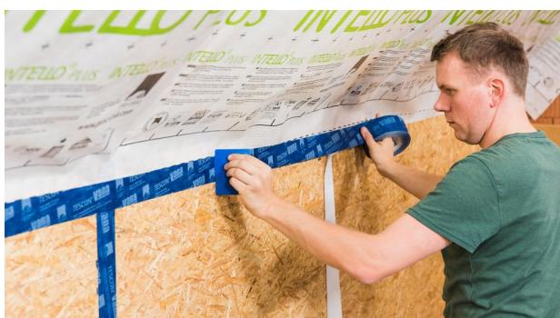
**3. Для соединения пароизоляции с гладкими неминеральными поверхностями,**
