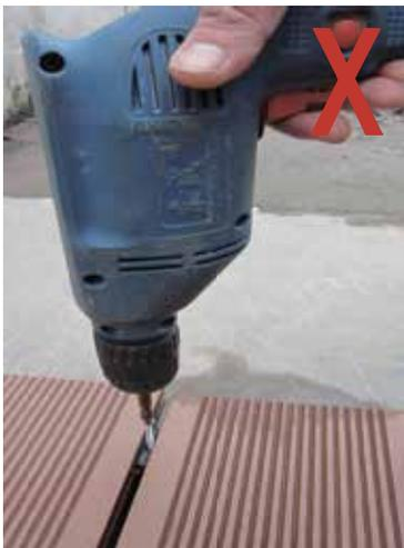
6. Монтаж декинга осуществляется на скрытые клипсы, нельзя вкручивать крепеж прямо в основной профиль ДПК (это приведет к нарушению геометрии). Пожалуйста, производите предварительное просверливание при помощи специальной головки (1мм в диаметре), после чего вкрутите саморезы через клипсы в предварительные отверстия.
