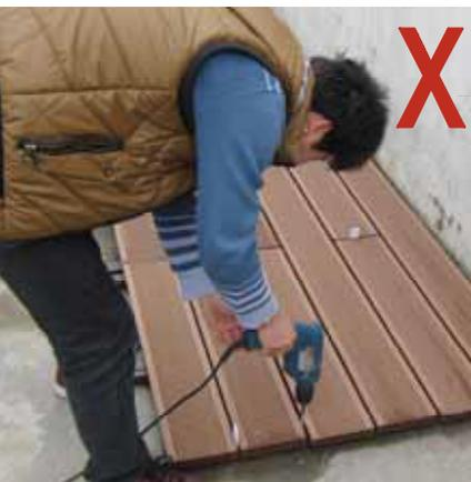
14. При монтаже декинга ДПК, пожалуйста, используйте каску, наколенники, а также производите монтаж в хорошо проветриваемом месте. Перед монтажом, подготовьте весь инструмент в безопасном месте. Сверление и распиловка распространяют пыль и шум, что может доставить дискомфорт окружающим, в случае необходимости, примите меры предосторожности.
