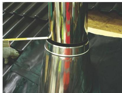
3. Отцентрировать проход через кровлю относительно дымоходной трубы.
