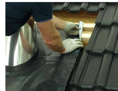
8.1 Сформируйте на боковых и верхних краях проходного элемента кровли дренажные барьеры согласно рекомендациям производителя кровельного покрытия.<sup>1</sup>
