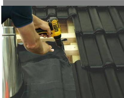
9. Закрепите проходной элемент в верхней части на дополнительную обрешетку тремя кровельными саморезами.
