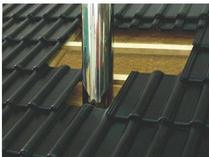
1. Разобрать кровельное покрытие вокруг дымоходной трубы.
