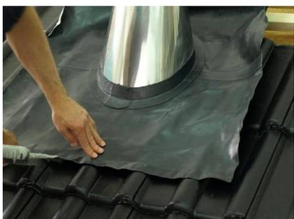
4. Нанести кровельный герметик под проход через кровлю.
