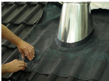
5. Разгладить эластичную часть проходного элемента по форме кровельного покрытия.
