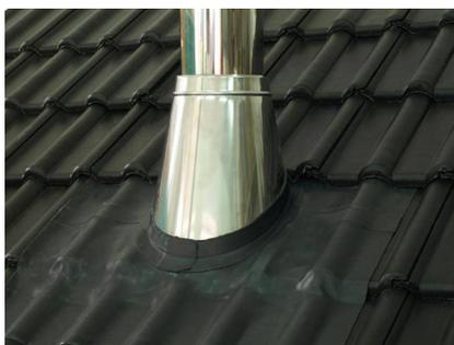
12. Проверьте стыковку кровельного покрытия и герметичность стыков.
