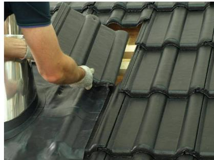
10. Подрежьте кровельное покрытие, чтобы выполнить примыкание к дымоходной трубе.
