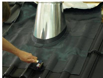
6. При помощи валика окончательно разгладьте эластичную часть проходного элемента.
